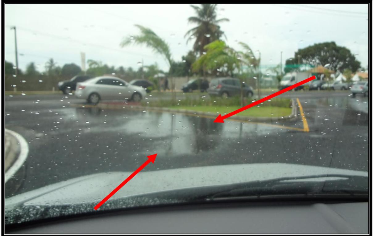
Problemas de topografia quanto ao greide da via de rolamento, áreas com acúmulo de água proporcionando empoçamento e prejudicando o projeto de drenagem executado
