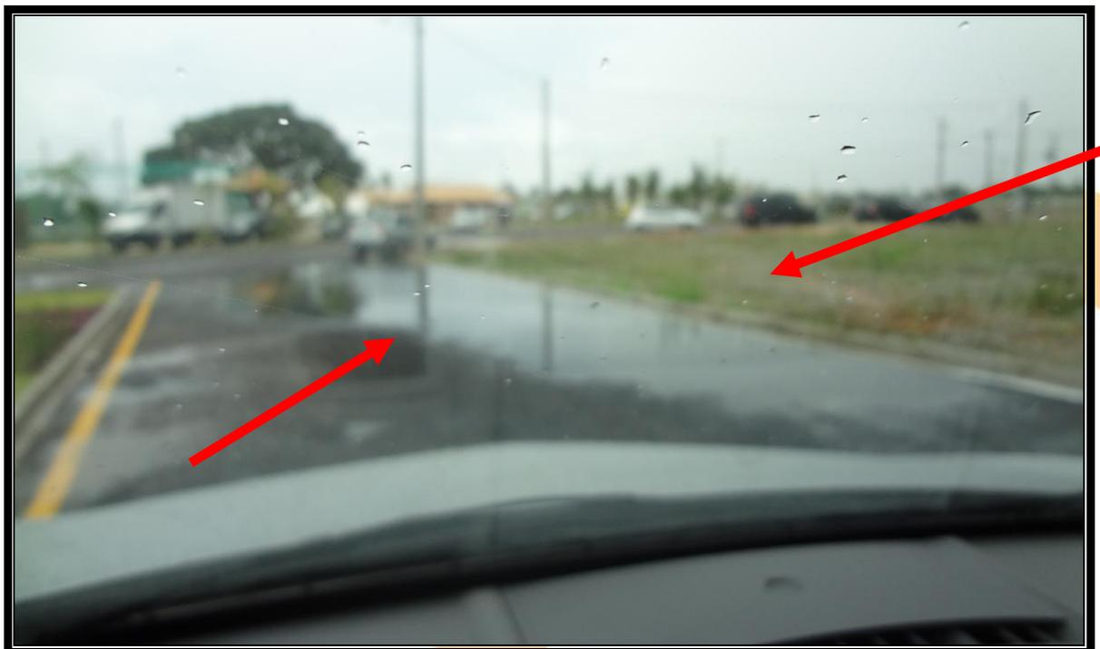
Problemas de topografia quanto ao greide da via de rolamento, áreas com acúmulo de água proporcionando empoçamento e prejudicando o projeto de drenagem executado
