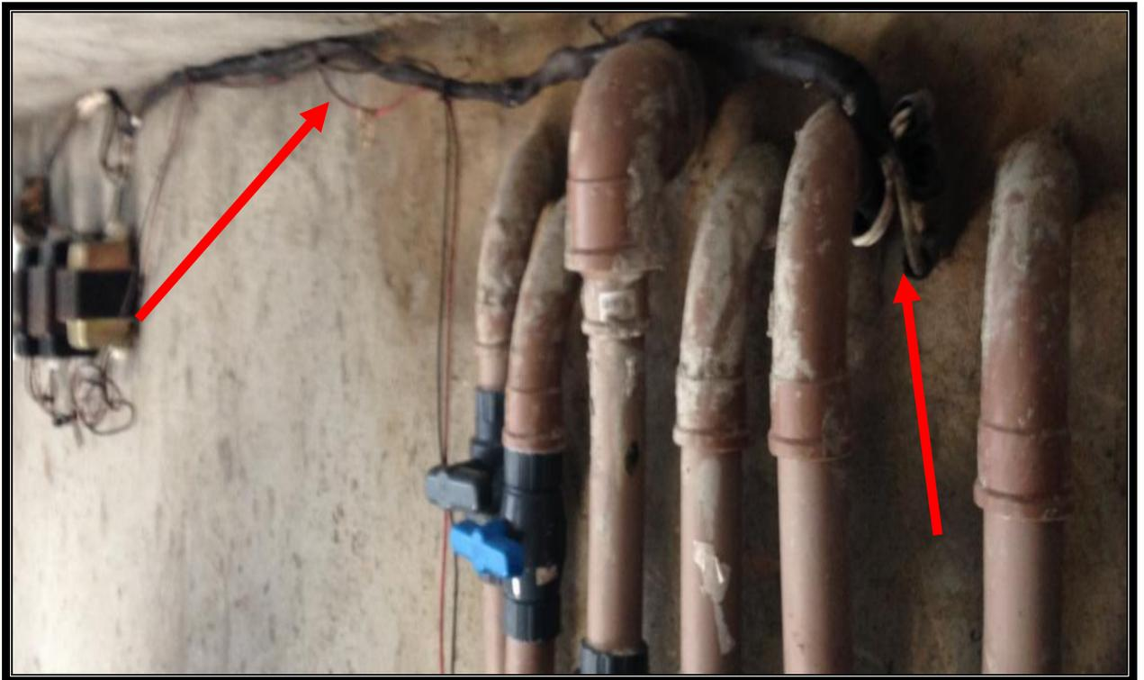
Instalações da casa de bombas das piscinas inadequadas – risco de acidente de trabalho
