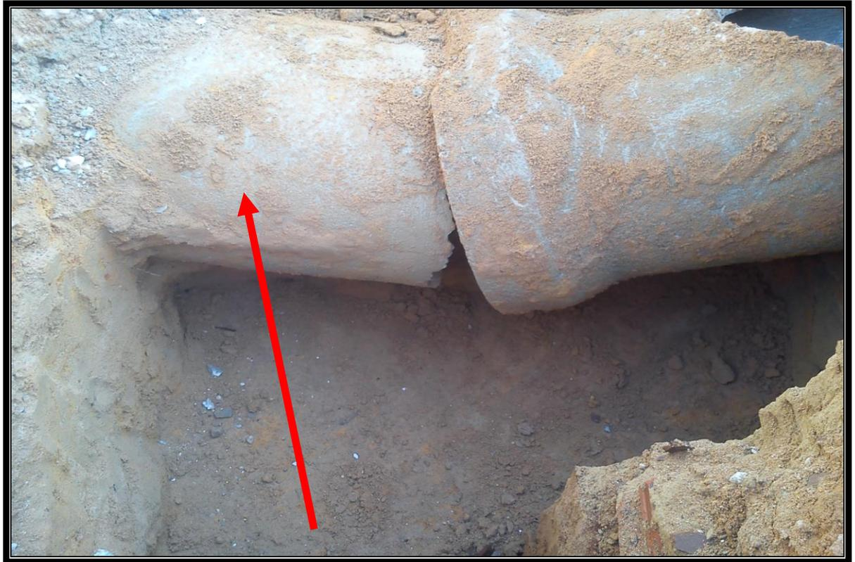
Tubos de concreto da rede de drenagem que ligam ao sumidouro danificados
