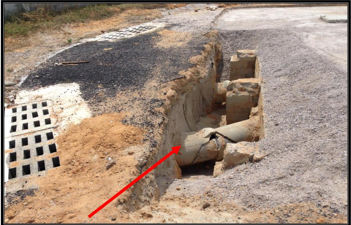
Tubos de concreto da rede de drenagem que ligam ao sumidouro danificados
