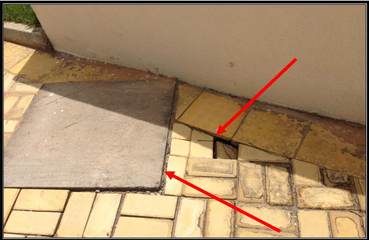
Pavimento do passeio comprometido em função da compactação e drenagem
