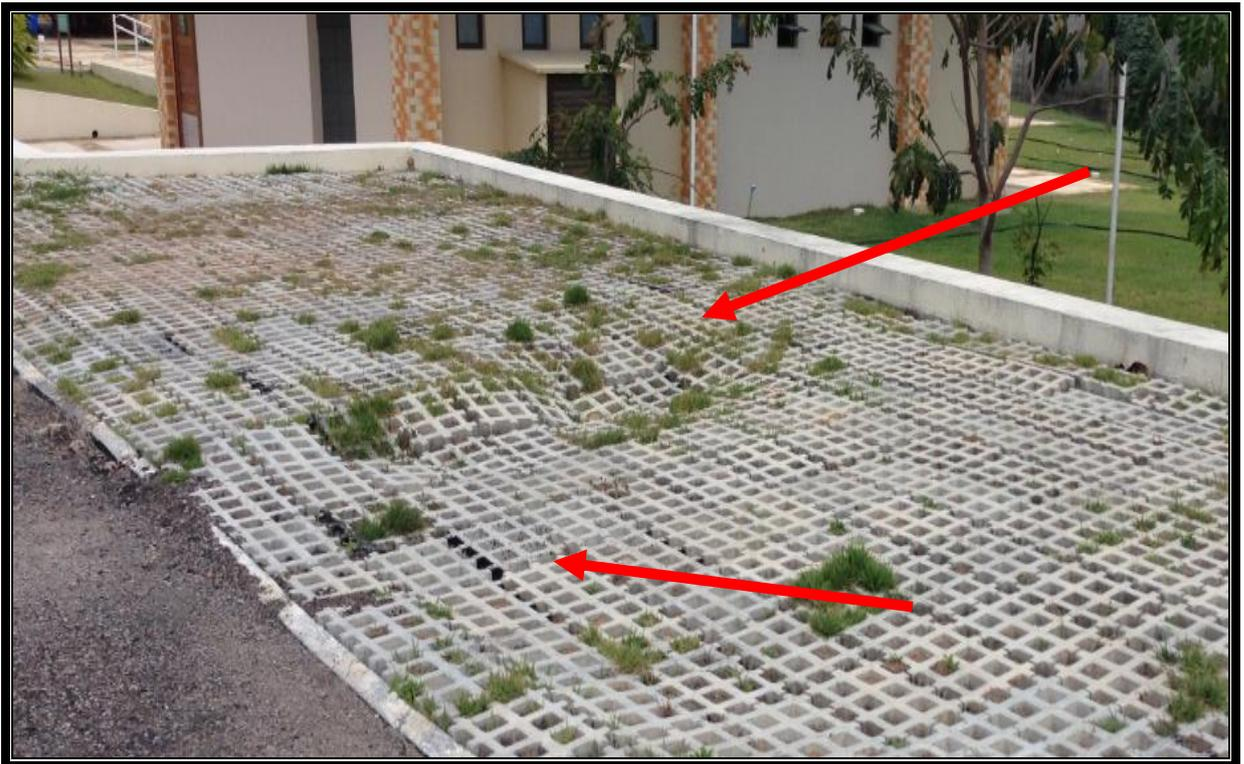
Pavimento do passeio comprometido em função da compactação e drenagem
