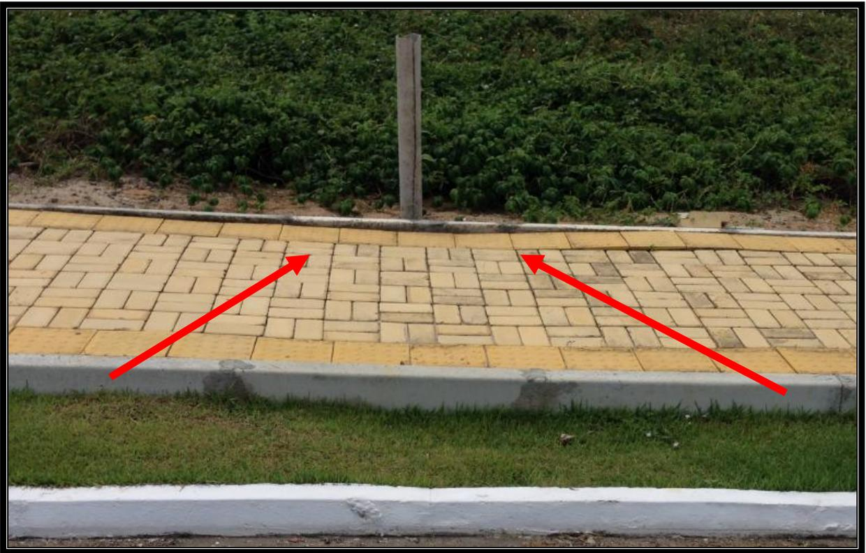
Pavimento do passeio comprometido em função da compactação
