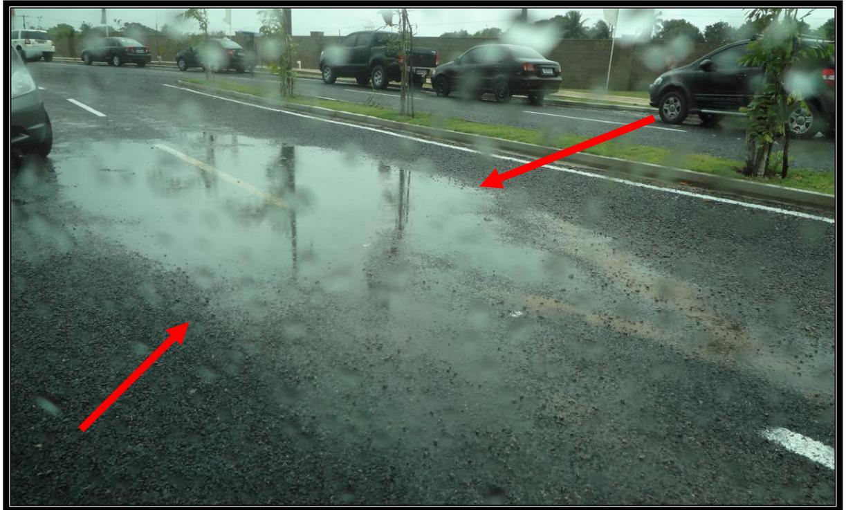
Problemas de topografia quanto ao greide da via de rolamento, áreas com acúmulo de água proporcionando empoçamento e prejudicando o projeto de drenagem executado
