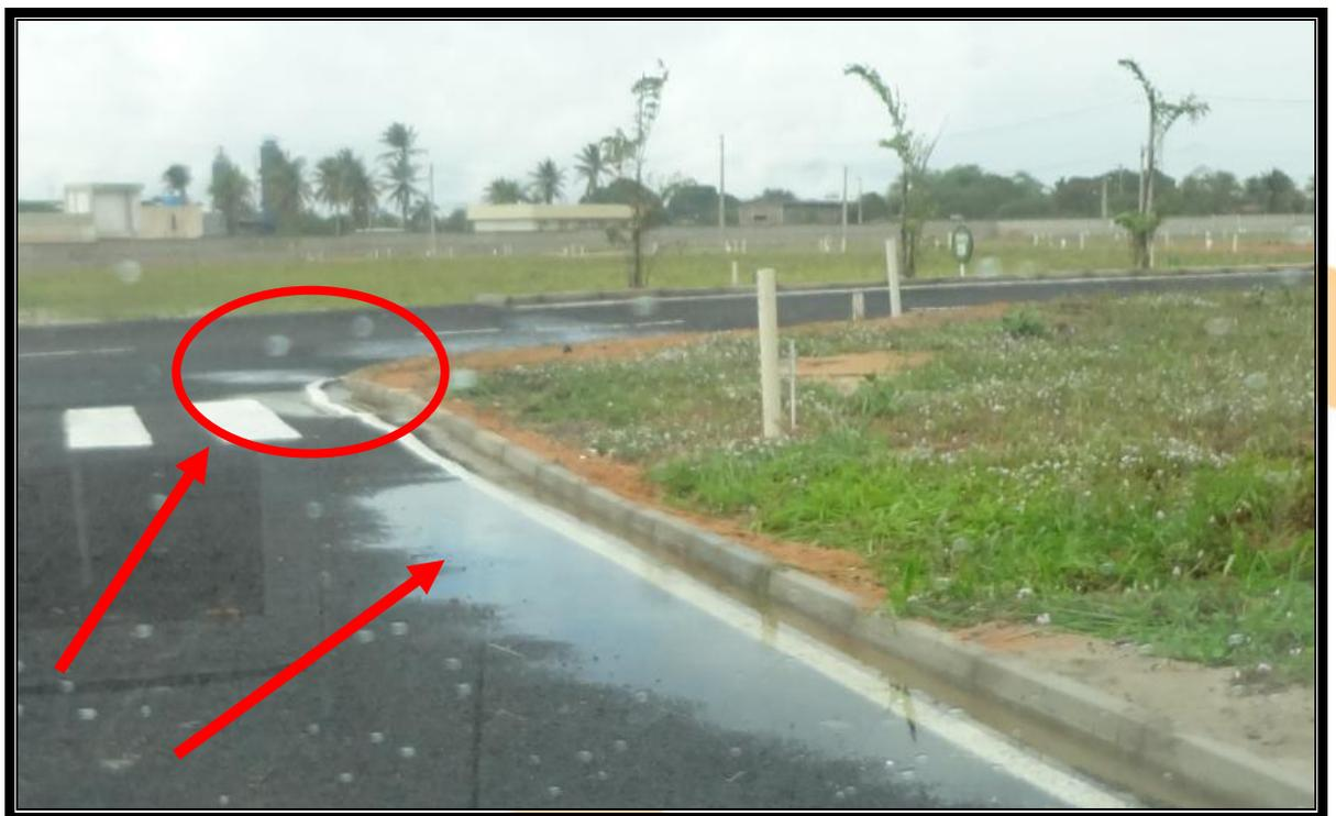
Problemas de topografia quanto ao greide da via de rolamento, áreas com acúmulo de água proporcionando empoçamento e prejudicando o projeto de drenagem executado – boca de lobo para escoamento logo após
