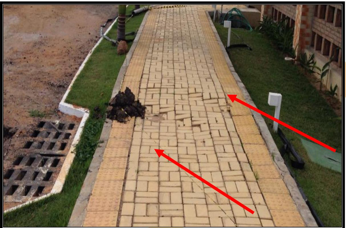
Pavimento do passeio comprometido em função da compactação e drenagem
