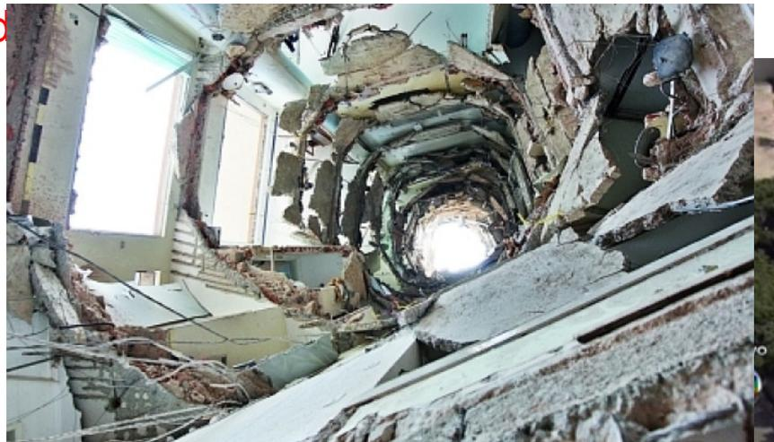
O acidente foi causado por infiltrações de água e ar que comprometeram a dureza e resistência dos materiais da primeira laje que desabou. O laudo também apontou que as vigas usadas na construção do prédio não tinham a espessura correta.
