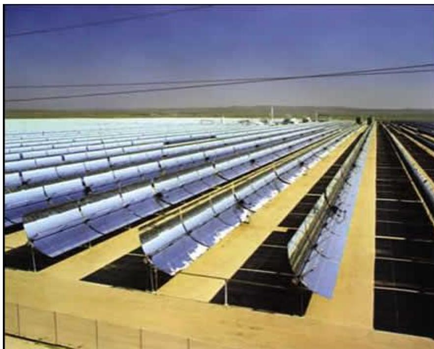
Figura 11: Conjunto de coletores solares côncavos, disponível em: < [http://www2.aneel.gov.br/aplicacoes/atlas/energia\\_solar/3\\_3.htm](http://www2.aneel.gov.br/aplicacoes/atlas/energia_solar/3_3.htm) >. Acesso em 02/06/2016.
