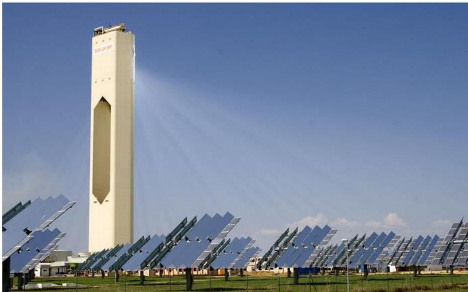
Figura 17: Detalhe do elemento concentrador do tipo torre, disponível em: < [https://pt.wikipedia.org/wiki/Energia\\_heliot%C3%A9rmica](https://pt.wikipedia.org/wiki/Energia_heliot%C3%A9rmica) >, acesso em 02/06/2016.
