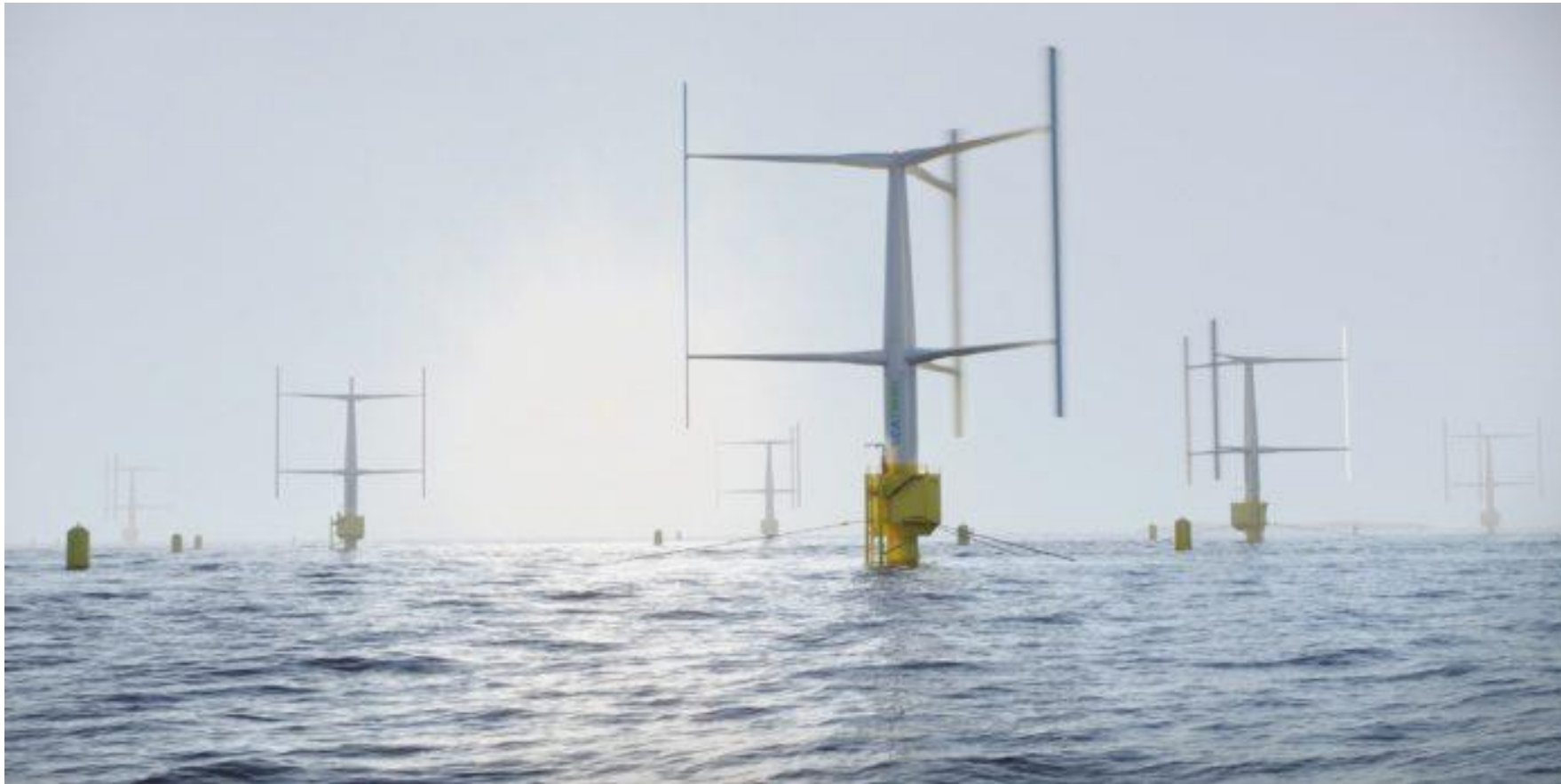
Figura 5: Exemplo de turbina eólica de eixo vertical em aplicação offshore .
