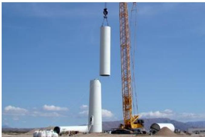
Figura 13: Exemplo de montagem de um aerogerador.
