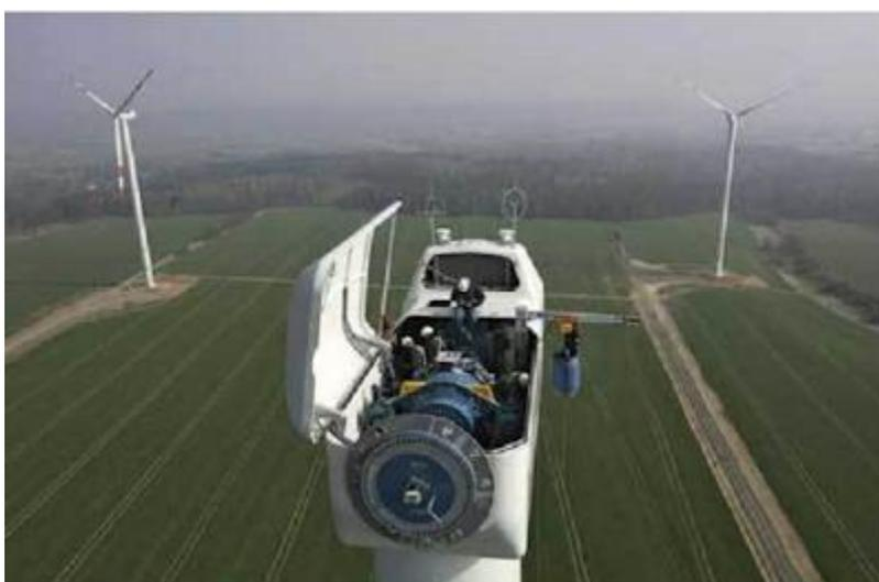
Figura 23: Estrutura da Nacele.
