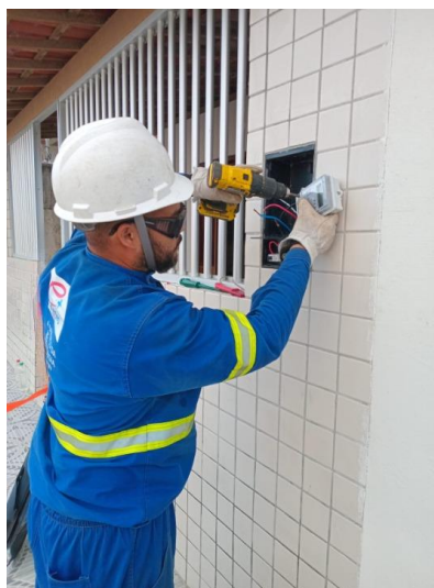
Troca de medidor mono
