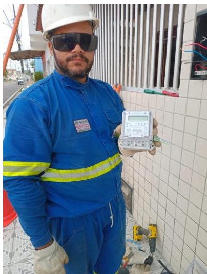
Troca de medidor mono
