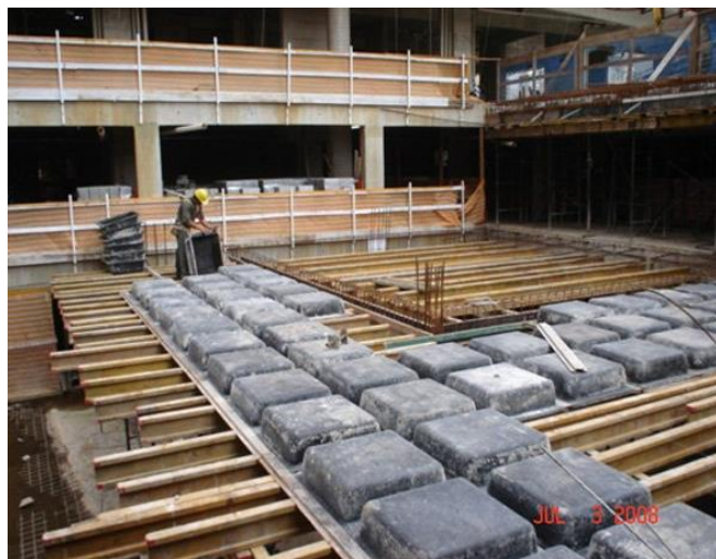
Figura 8. Detalhe colocação cubetas.
