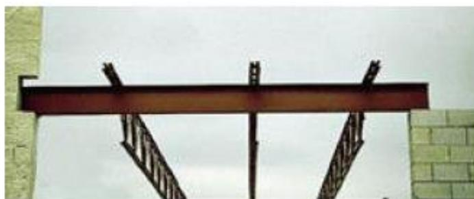
**FIGURA 71.** Viga metálica biapoiada.
