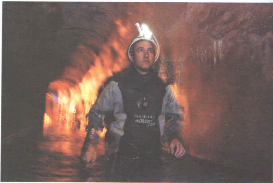
Aqua Virgo, o único aqueduto ainda em uso após 20 séculos. Foto de 2006.
