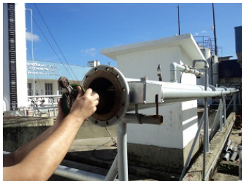
PIG no Lançador.
