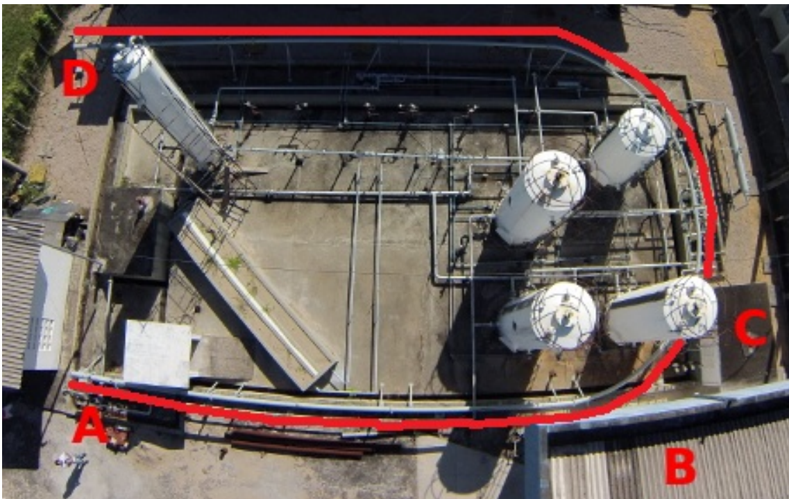
Figura 4.3: Vista Aérea do Laço de Teste de \phi 6'' de Diâmetro.
