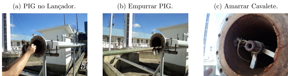
Figura 4.12: Continuação dos Procedimentos no Lançador.
