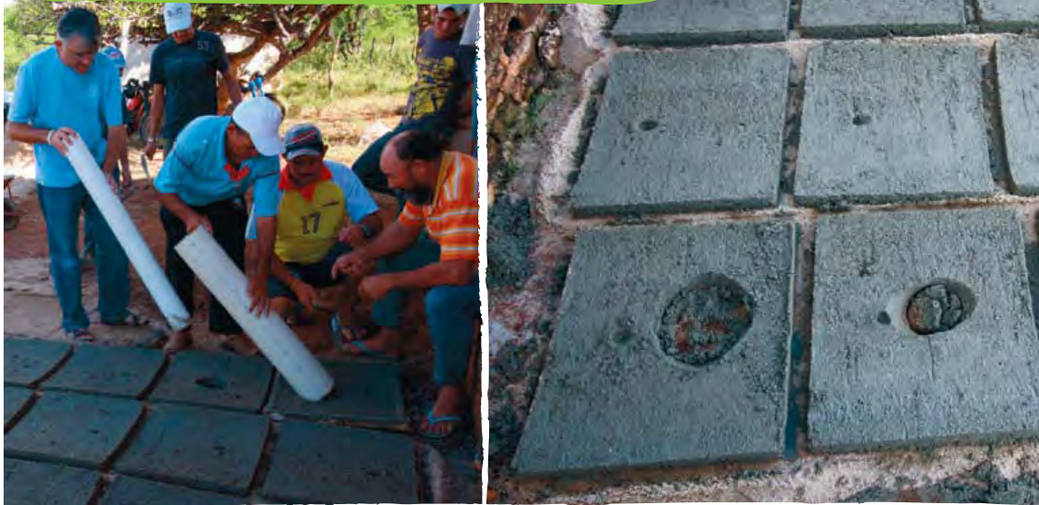
[Figura 6] Preparação dos furos de entrada e saída das tubulações de carga e descarga
