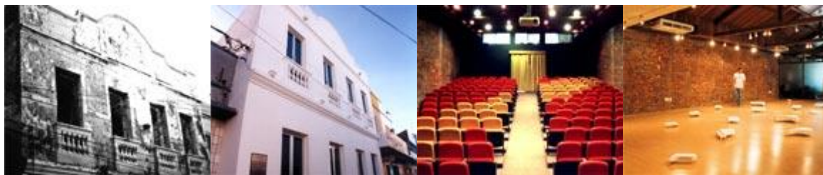
Figura 3: Casa da Ribeira antes e depois da reforma. Fonte: www.casadaribeira.com.br
