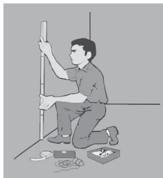
Fig. 11 – Medindo altura
