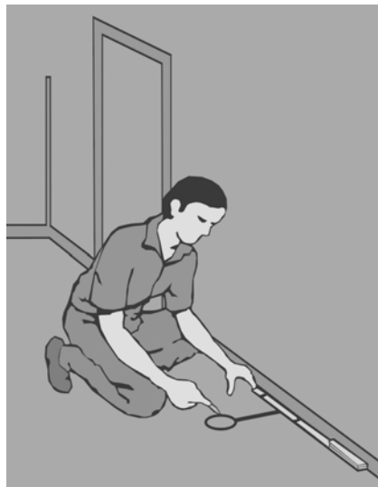
Fig. 14 – Marcando no chão a posição do interruptor
