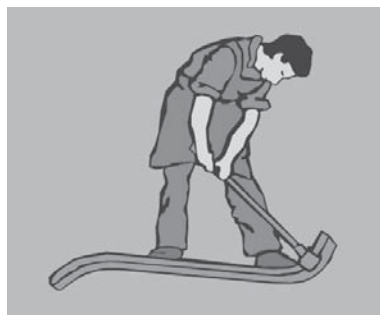
Fig. 36 – Preparando a curvatura do eletroduto
