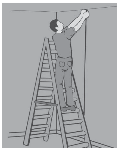
Fig. 18 – Marcando o percurso da instalação na parede
