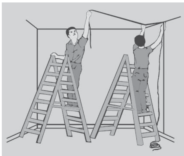
Fig. 19 – Marcando o percurso da instalação no teto
