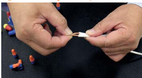
Figura 166 - Torçendo as pontas dos fios
