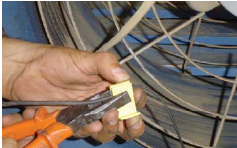
Figura 168 - Exemplo de Conexão de condutores elétricos em derivação.
