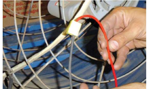
Figura 168 - Exemplo de Conexão de condutores elétricos em derivação.
