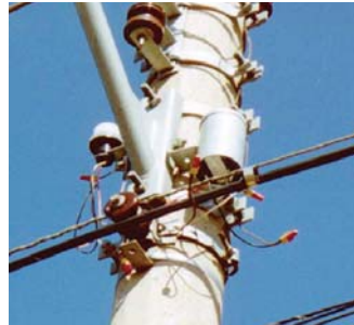
Figura 163 - Exemplos de aplicação de conectores de torção
