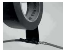
Figura 160 - Aplicando a primeira camada da isolação
