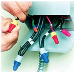
Figura 163 - Exemplos de aplicação de conectores de torção
