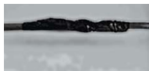
Figura 162 - Isolação Finalizada
