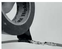
Figura 159 - Iniciando a isolação
