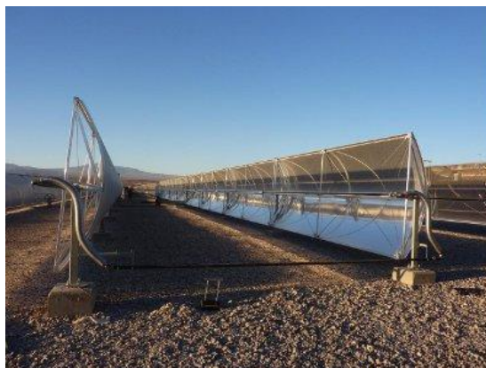
Ilustração 16: campo de coletores cilíndrico parabólicos da Mineração El Tesoro ( http://www.abengoasolar.com )
