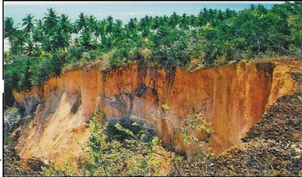
Erosão em encosta no litoral do Ceará (2003).
