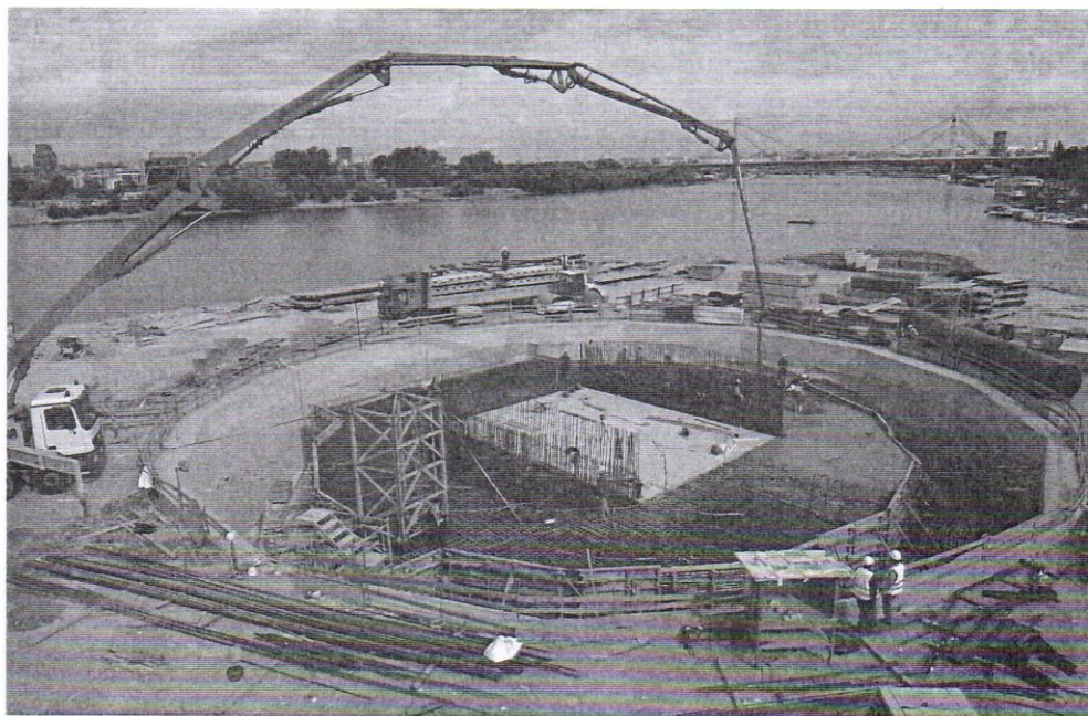
Figura 6.10 – Caminhão-bomba com lança telescópica em aplicação de concreto em obra.
