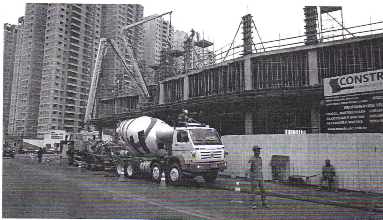
Figura 6.6 – Conjunto caminhão betoneira e caminhão bomba de concreto com a lança ainda sendo esticada para o início da concretagem.
