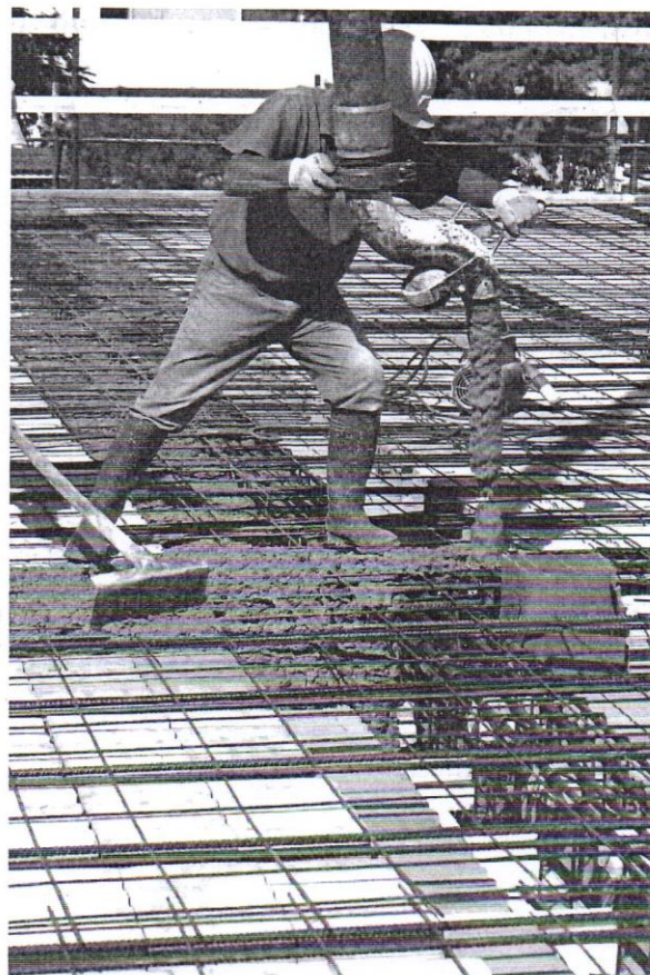
Figura 6.8 – Uso de bomba de concreto para aplicação em laje pré-moldada. Observe que as tabelas (peças que preenchem o vazio entre as vigotas da laje) são cerâmicas. Veja o funcionário sustentando e dirigindo o mangote da bomba de concreto. Neste caso a bomba é telescópica.
