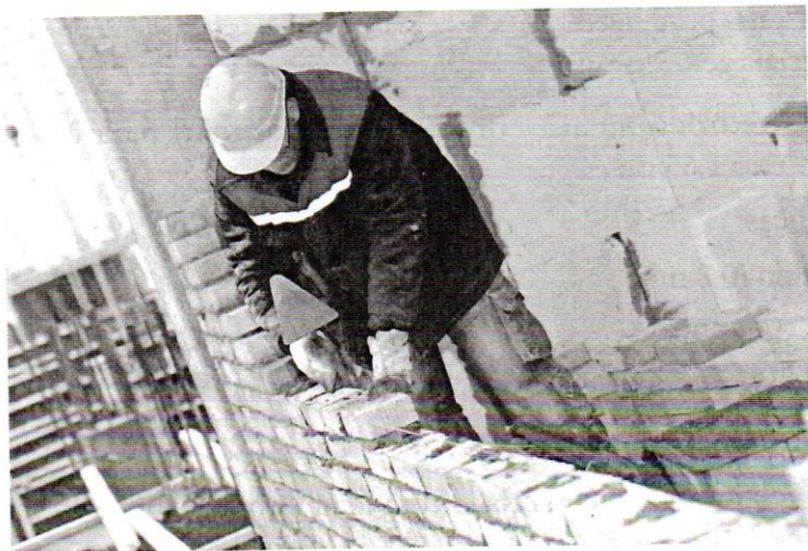
Figura 4.5 - Pedreiro assentando tijolos de barro recozido.
