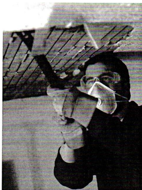
Figura 1.2 - (a) Demolição manual de um forro de madeira. (b) Demolição mecanizada da edificação.
