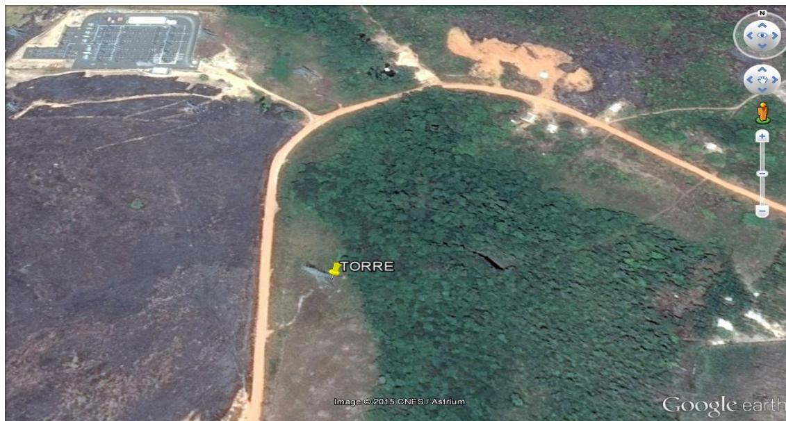
Figura 1.4: Imagem GPS da torre de alta tensão
