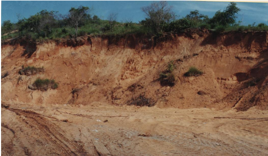
Foto 01 : Supressão da vegetação de área de preservação permanente.
