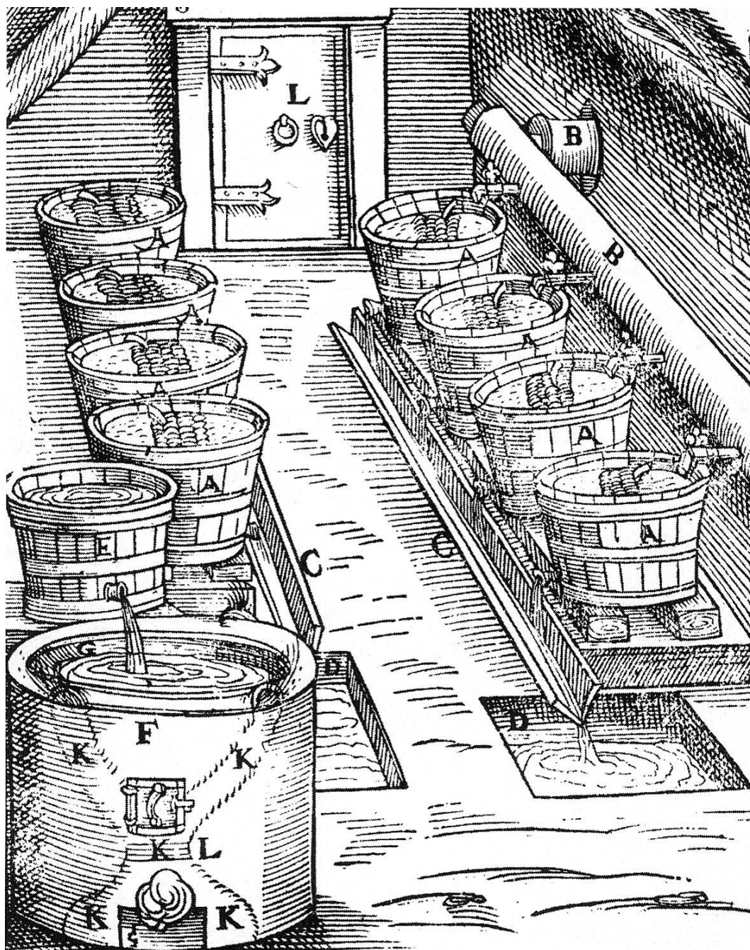
Figura 15 ■ Etapas da lixiviação e concentração (por ebulição) do salitre, obtido de esterco envelhecido de carneiro (Ercker, vide Fig. 4).
