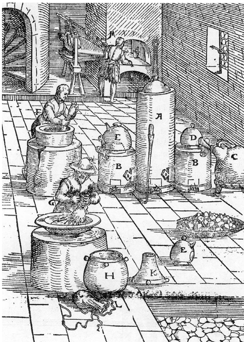
Figura 10 ■ Uso do mercúrio para dissolver o ouro contido no concentrado do minério. O amálgama de ouro é aquecido em seguida, e o mercúrio é destilado (Ercker, vide Fig. 4).
