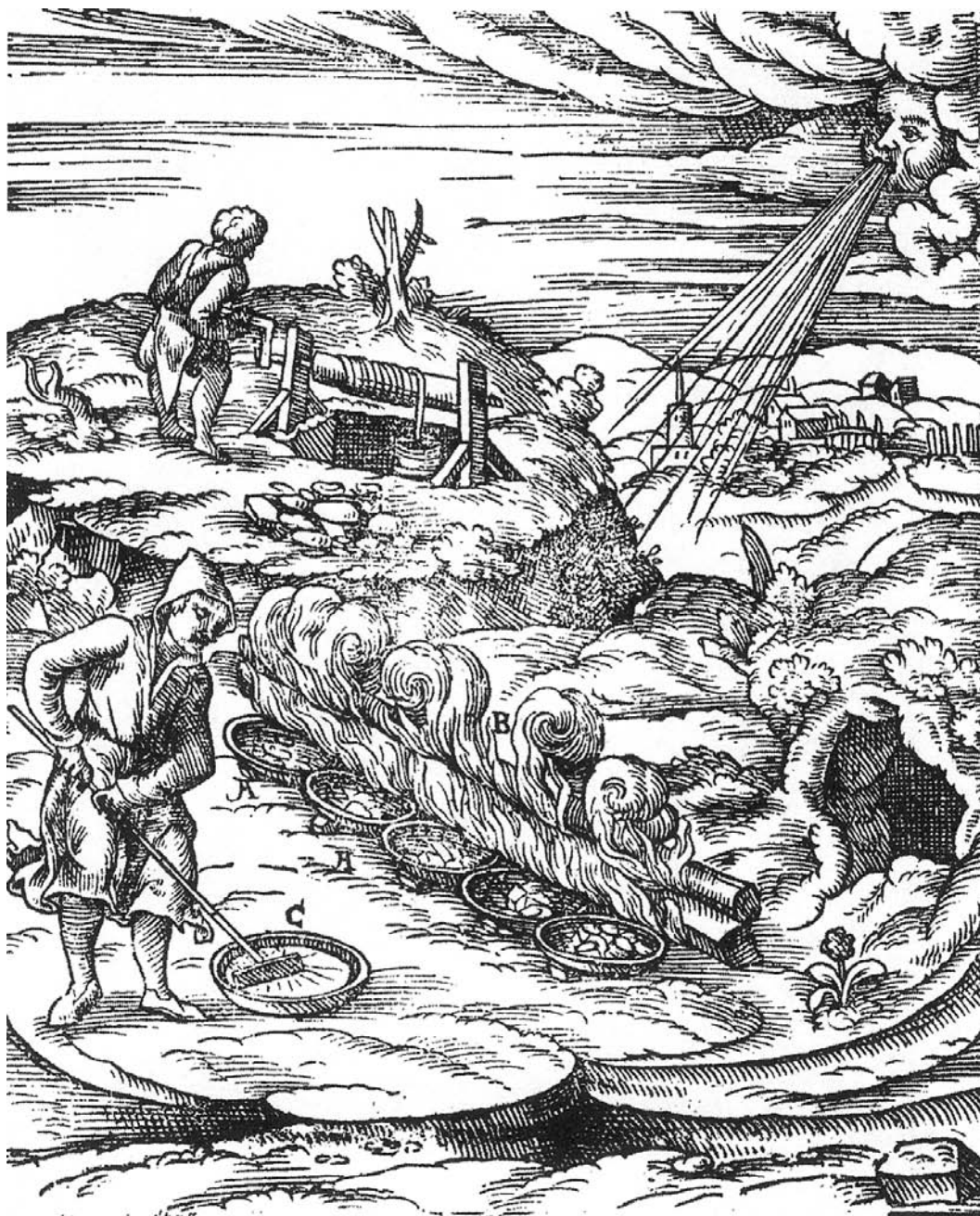
Figura 14 ■ Redução de minério de bismuto a céu aberto; o bismuto fundido recém-formado flui para os recipientes (Ercker, vide Fig. 4).
