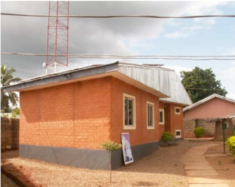
Figura 11.2: O centro de operações foi construído localmente com tijolos de laterita, produzidos por jovens na cidade de Kafanchan.
