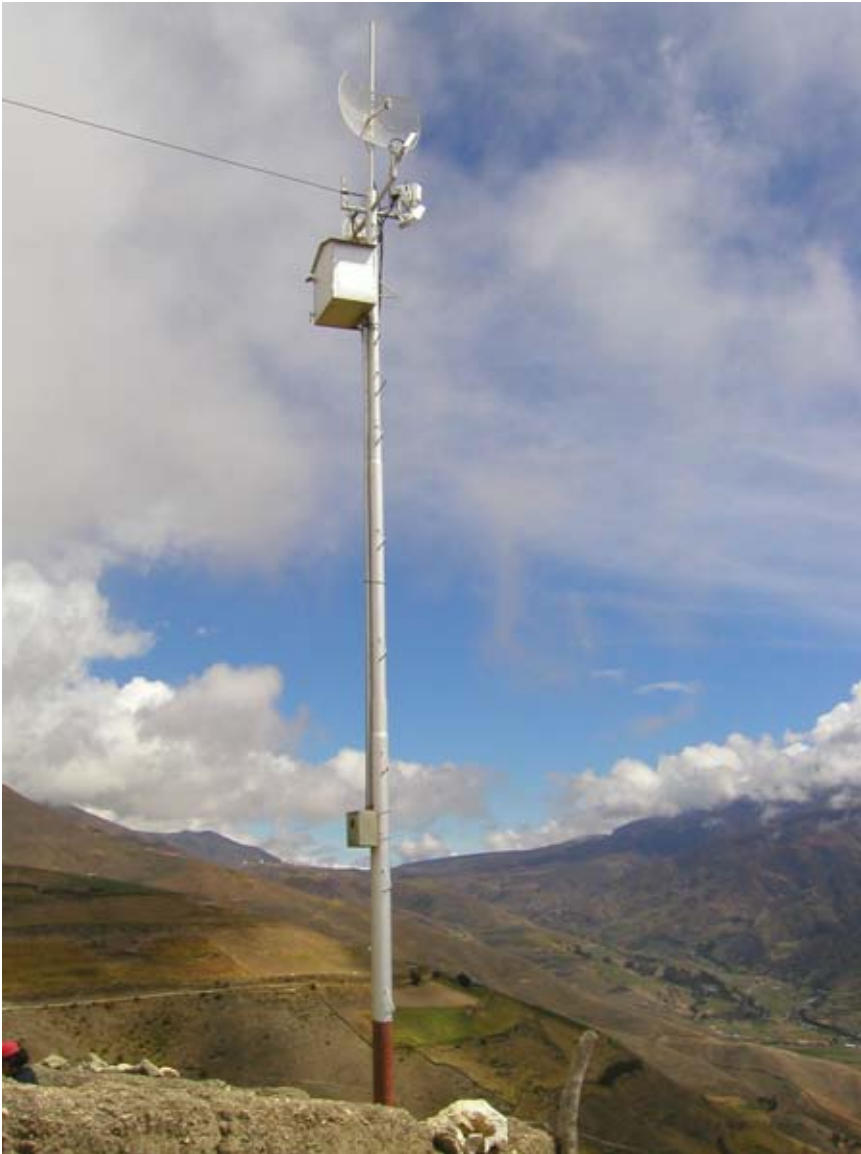
Figura 8.3: Uma torre auto-sustentável simples.
