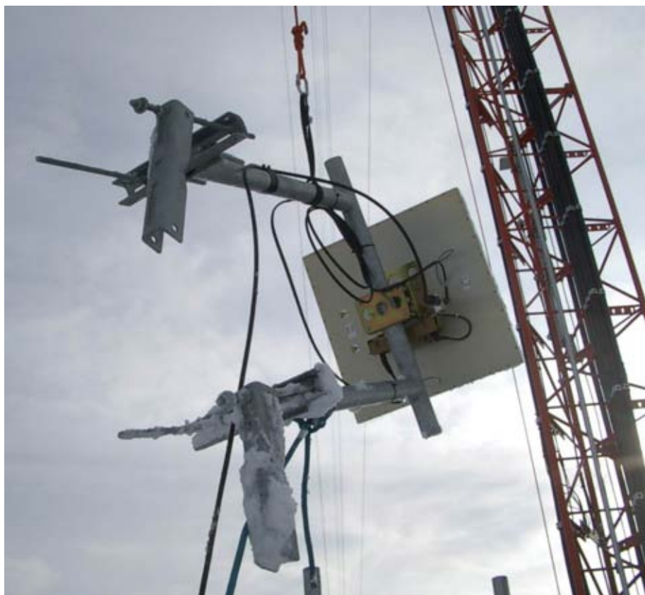
Figura 8.1: Uma antena com seu suporte sendo alçada em uma torre.
