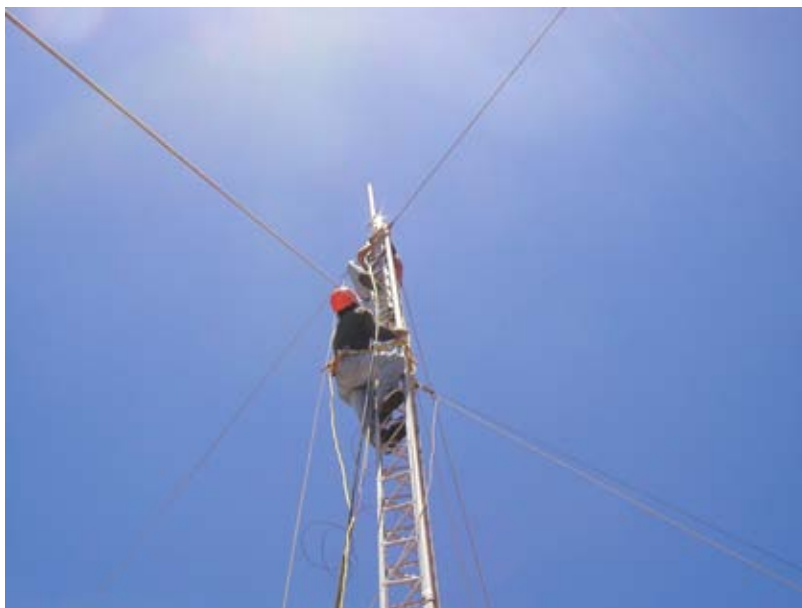
Figura 8.2: Uma torre estaiada escalável.
