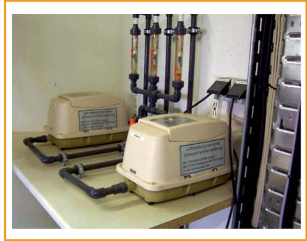
Figura 6.1: Controle de gás para sopramento de ar no gasômetro do biodigestor [DBFZ]
