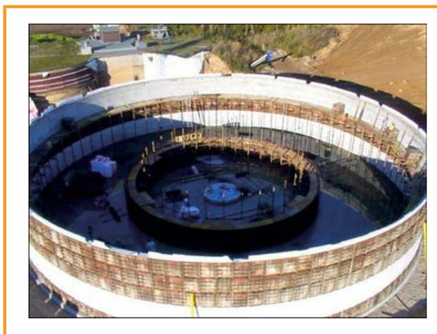
Figura 3.29: Construção de um biodigestor de concreto [Johann Wolf GmbH & Co Systembau KG]
