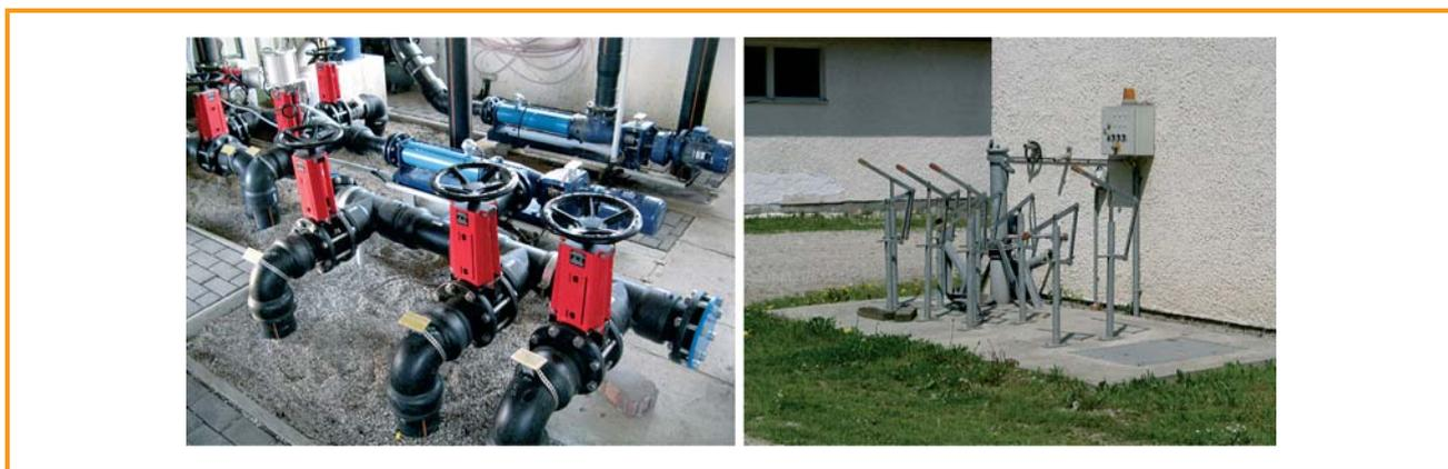
Figura 3.20: Tubulações e válvulas em uma estação de bombeamento, válvulas de gaveta [DBFZ]
