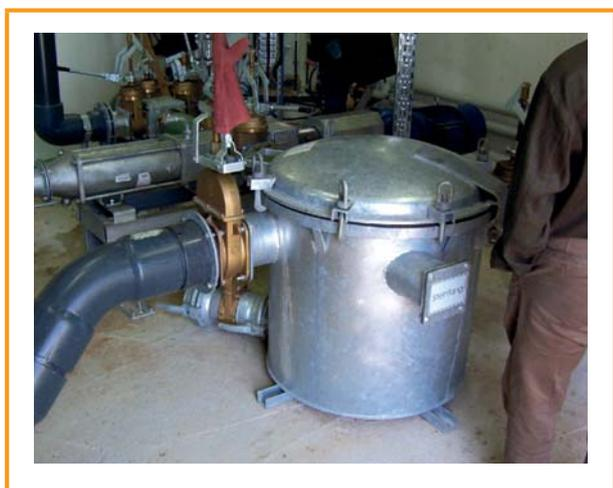
Figura 3.5: Separador de materiais pesados em tubulação [DBFZ]
