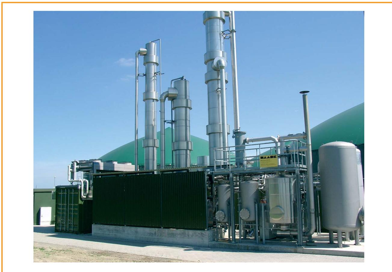
Figura 6.3: Estação de tratamento de biogás (lavagem Genosorb) em Ronnenberg [Urban, Fraunhofer UMSICHT]
