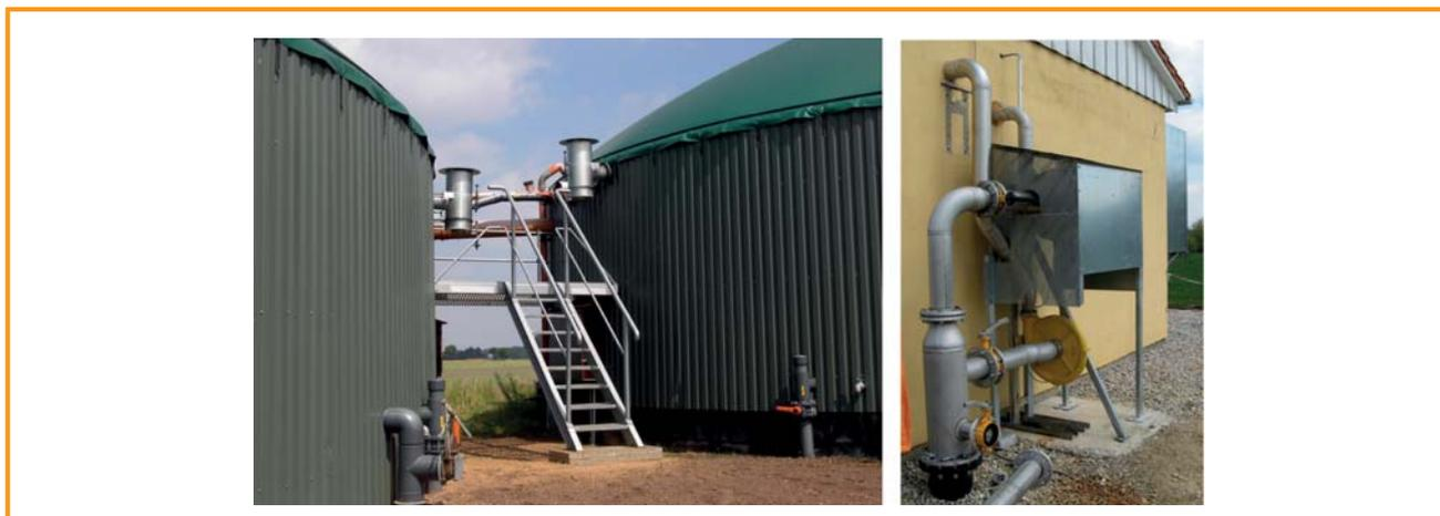
Figura 3.21: Plataforma de trabalho entre dois reservatórios com tubulação e dispositivos de alívio de pressão (esquerda); tubulação de gás com soprador compressor (direita) [MT-Energie GmbH (esquerda), DBFZ (direita)]
