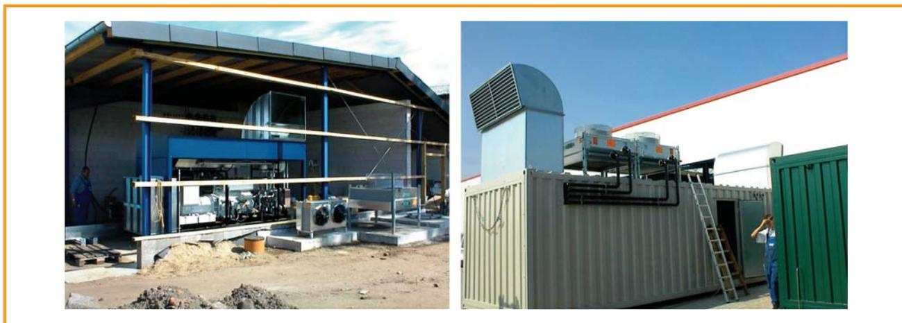
Figura 6.9: Construção de uma usina de cogeração em uma edificação ou em container [Seva Energie AG]
