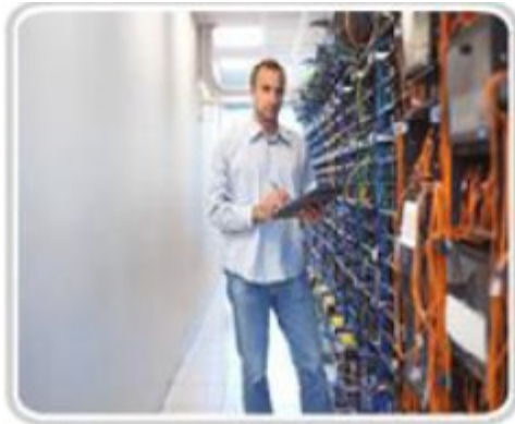
Verifique se há danos na instalação.
