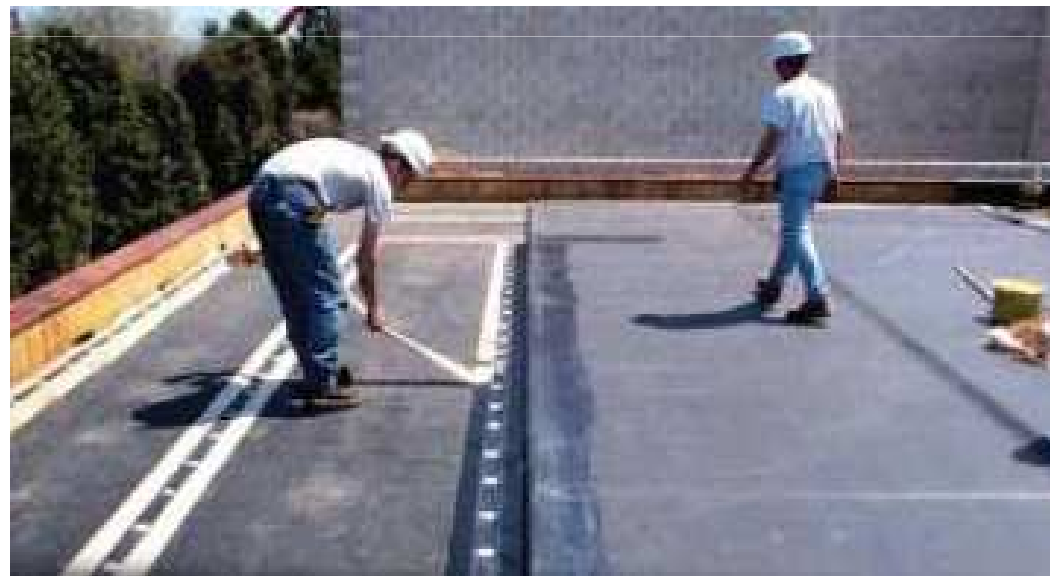
Colagem de emendas com fitas
