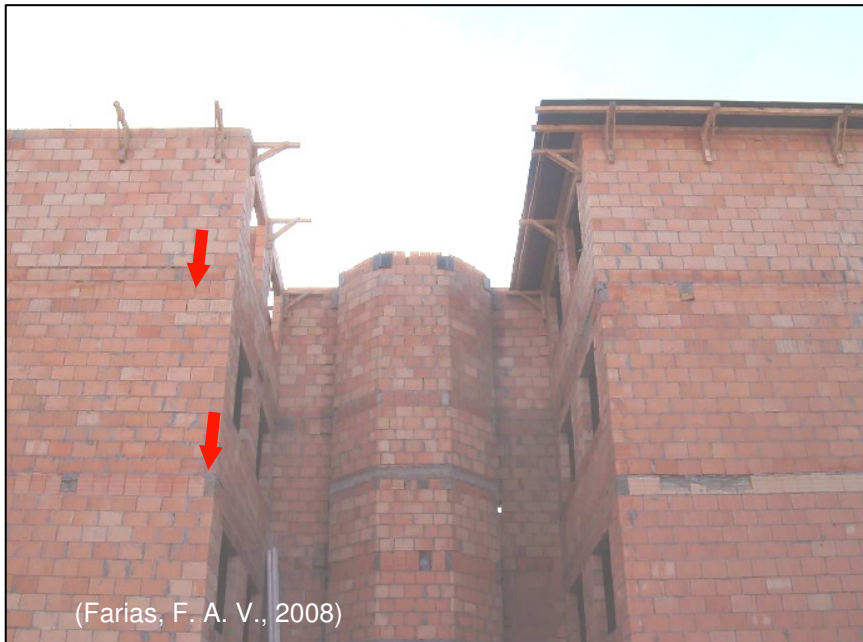
Lajes com bloco “J” e bloco compensador.
