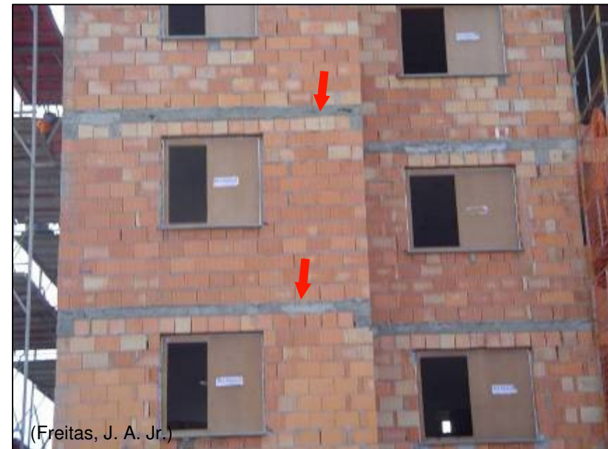
Lajes direto sobre o bloco canaleta.
