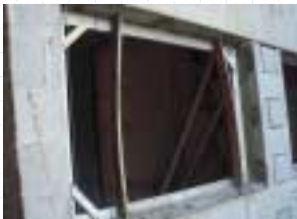
Fixação da esquadria de alumínio na alvenaria, por aparafusamento e colagem com silicone
