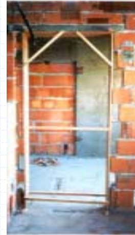
Chumbamento do batente de madeira na alvenaria
