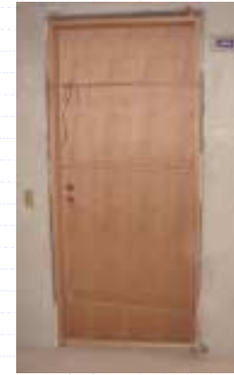
Fixação do batente de madeira na alvenaria, por colagem com espuma de poliuretano
