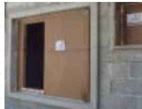
Fixação da esquadria de alumínio na alvenaria, por aparafusamento e colagem com silicone
