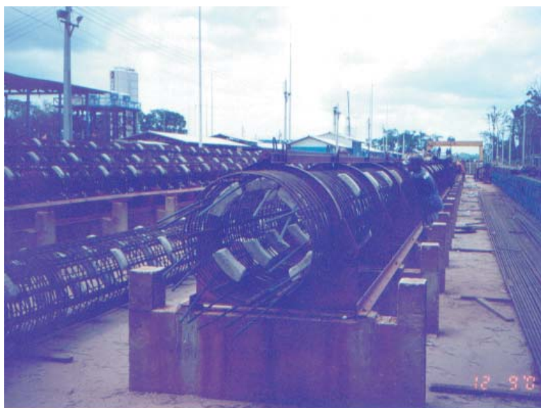
Fig. 21 – Armadura de estaca – Ponte Alça Viária.
