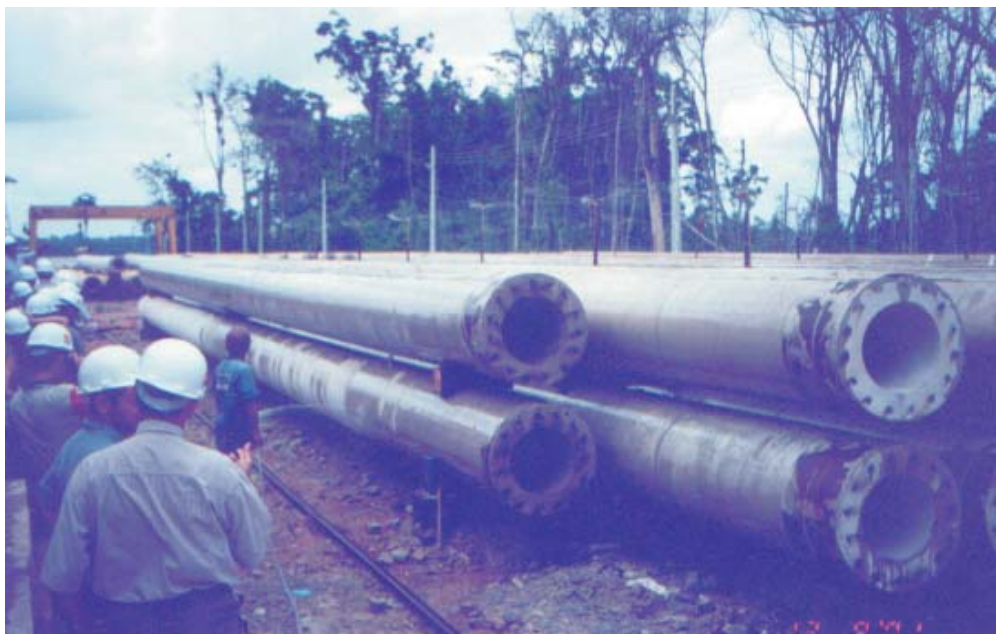
Fig. 23 – Secagem de estacas – Ponte Alça Viária.
