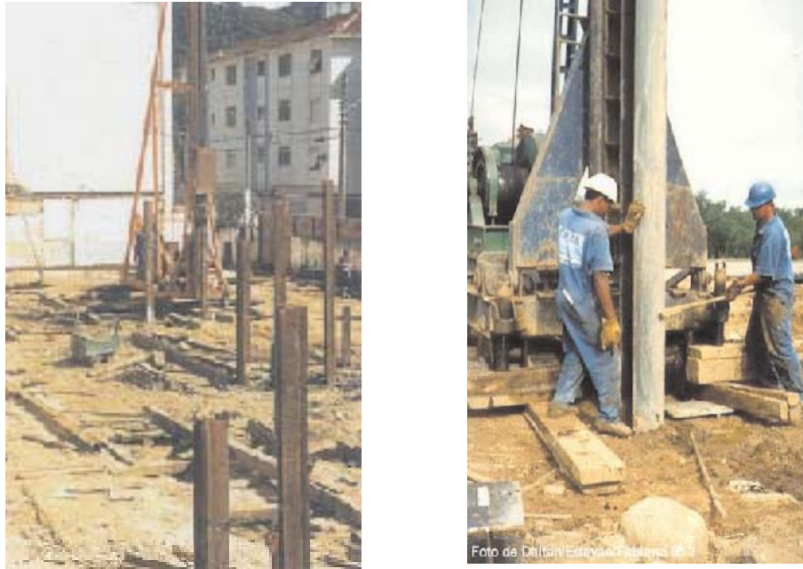
Fig. 25 – Cravação de estacas metálicas. Fonte: www.fundacoes.com.br
