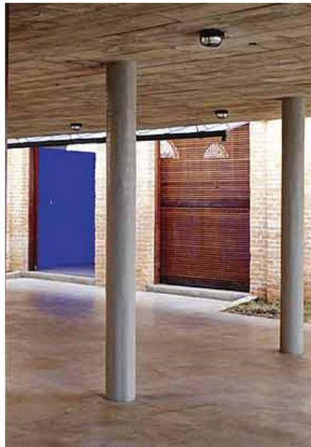
Figura 24 - Laje lisa (apoiada diretamente nos pilares).
