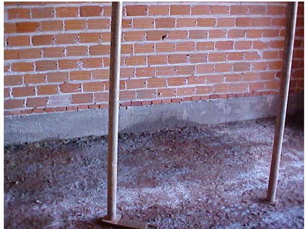
*Figura 35 – Viga invertida na base de uma parede.*
