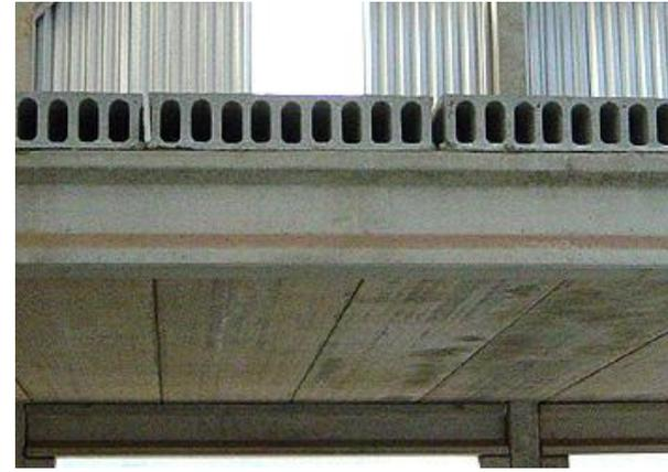
Figura 30 – Laje alveolar de concreto protendido (TATU PRÉ-MOLDADOS, 2004).
