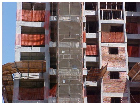
*Figura 42 – Pilares num edifício de múltiplos pavimentos.*
