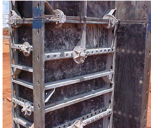
*Figura 40 – Pilar sendo concretado e detalhe da fôrma.*
