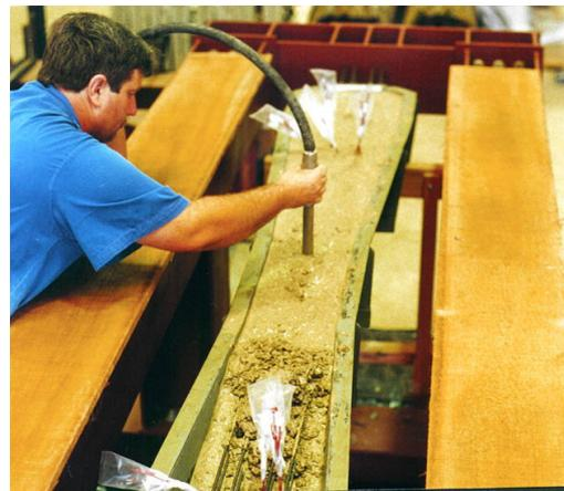
d) Adensamento com vibrador de agulha.
