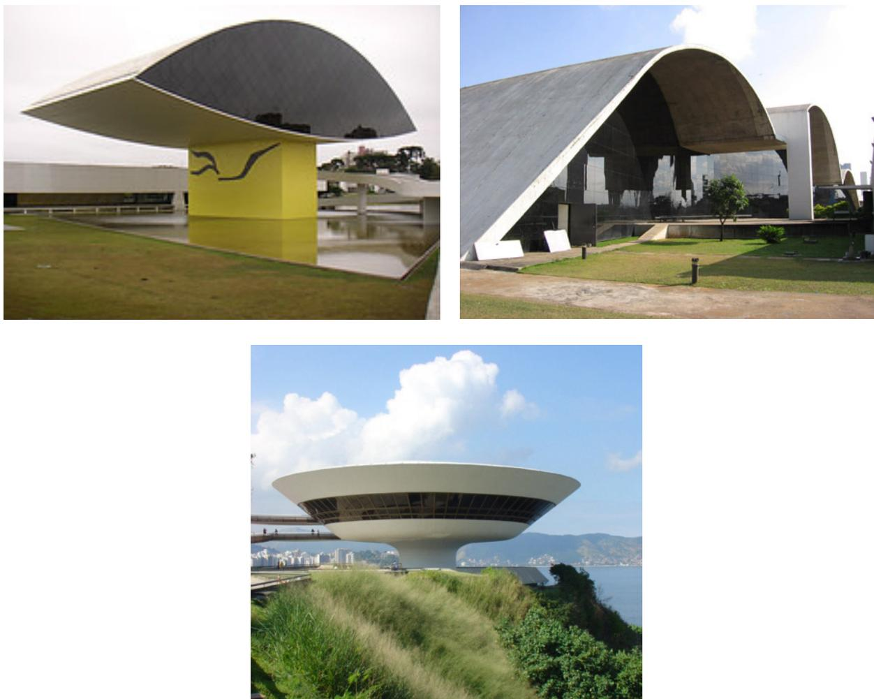
Figura 18 – Exemplos de estrutura em forma de casca.
