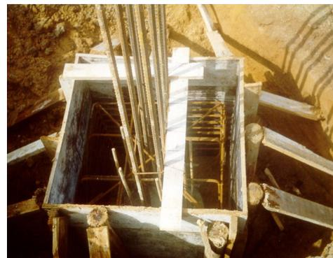
Figura 53 – Bloco sobre uma estaca em construção.
