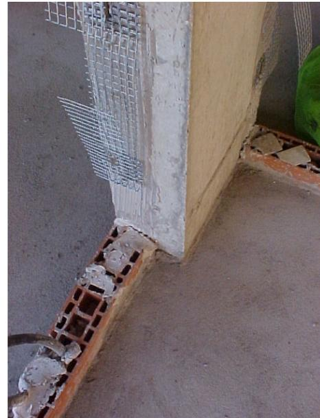
*Figura 44 – Detalhes da amarração entre o pilar de edifício e as paredes de vedação.*
