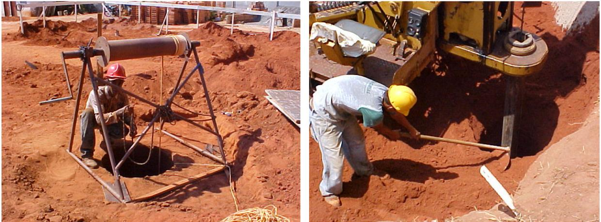
Figura 49 – Tubulões sendo escavados manualmente e com equipamento.
