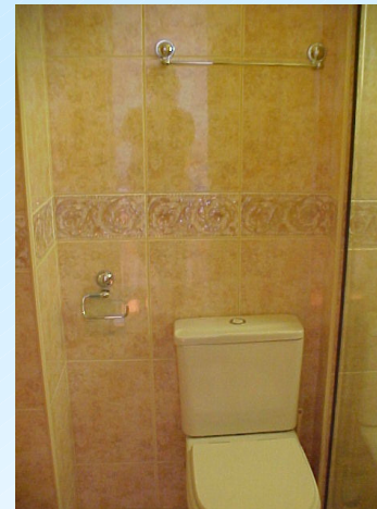
Revestimento interno de área molhada do edifício
