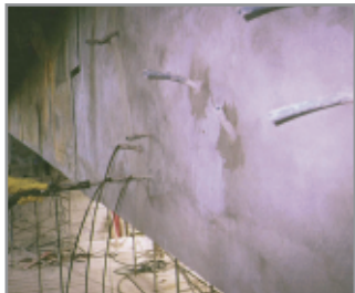
Foto 04 - Injeção de calda de cimento em trinca
