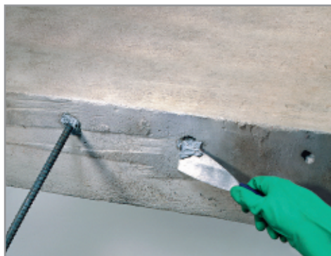
Foto 15 - COMPOUND ADESIVO TIX Chumbamento de Armadura com Epoxi
