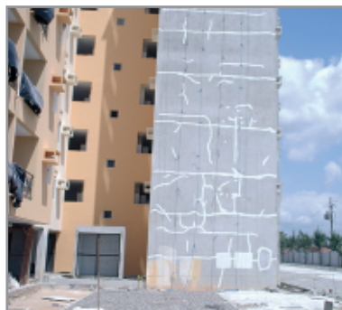
Foto 22 - Tratamento de trincas e fissuras com VEDATEX ANTIFISSURA e VEDAPREN PAREDE
