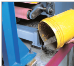
Foto 05 - Grauteamento - Base de equipamento
