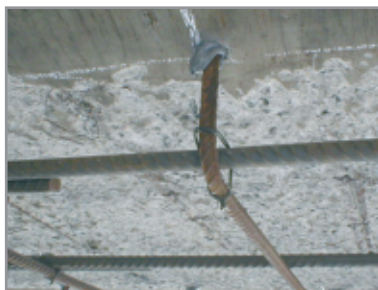
Foto 14 - Chumbamento de armadura com COMPOUND ADESIVO TIX
