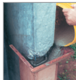
Foto 06 - Grauteamento em pilar de concreto
