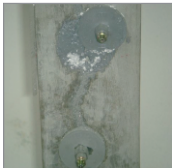
Foto 17 - Fixação de niples para injeção com COMPOUND ADESIVO TIX
