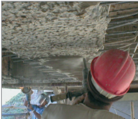
Foto 02 - Apicoamento Mecânico da superfície do concreto
