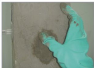
Foto 07 - Argamassa Estrutural 240 Recomposição de Pilar de concreto
