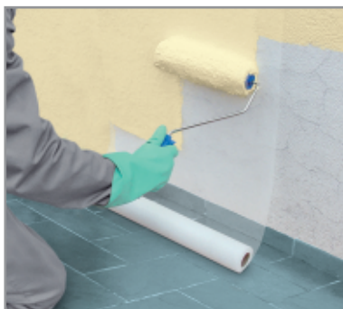
Foto 21 - Aplicação: VEDATEX ANTIFISSURA
