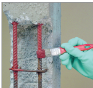
Foto 11 - ARMATEC ZN - Pintura anticorrosiva em armadura de concreto
