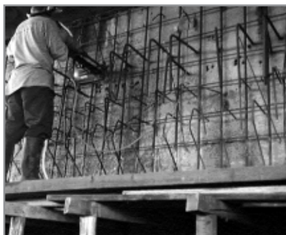
Foto 12 - Reforço de armadura
