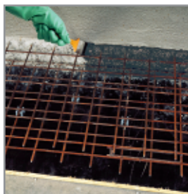
Foto 09 - Compound Adesivo PL Ponte de aderência Epoxi - Laje de concreto
