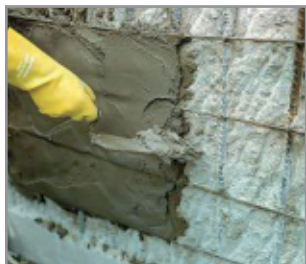
Foto 08 - Argamassa Estrutural 250 Recomposição de cobertura de armadura - viga de concreto
