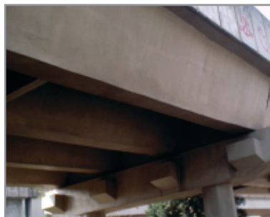
Foto 26 - COBERIT ACRÍLICO aplicado
