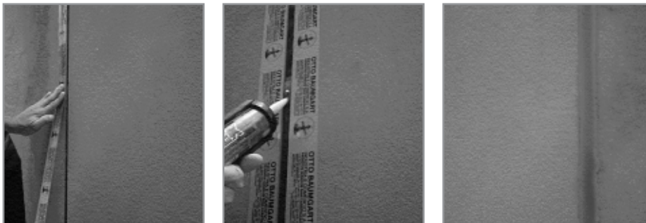
Foto 23 - Sequência de aplicação de mástique em junta de movimentação
