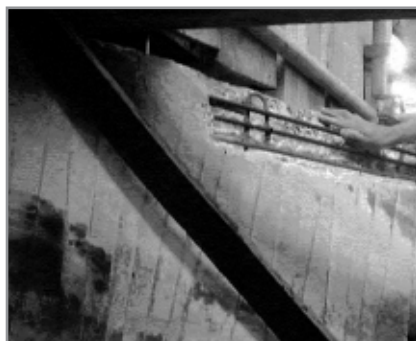
Foto 13 - Substituição de armadura
